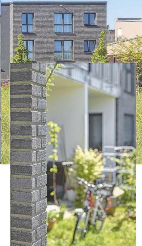
Harmonischer Kontrast: Die Sichtfugen der anthrazitfarbenen Gebäudehülle wurden zementgrau ausgeführt, was zur Klinkeroptik der Fassade bestens passt.
