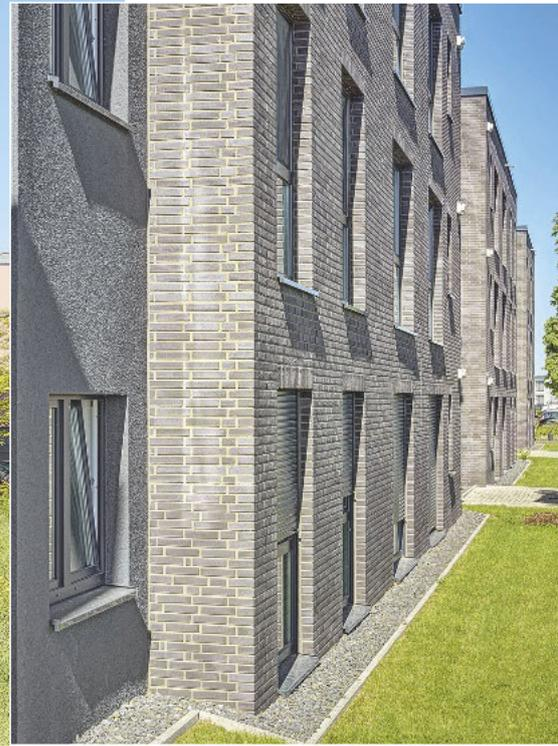
Nicht nur „äußere Werte“: Dank eines Wärmedämm-Verbundsystems auf Mineralwollbasis ist der Mehrgeschoss am Dortmunder Astrid-Lindgren-Ring auch energetisch vorbildlich.
